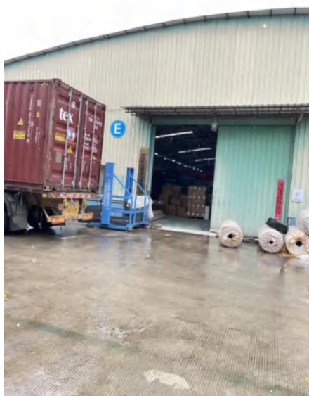
项目西南面 b：E 仓厂房
