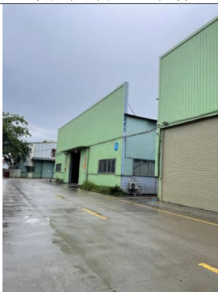
项目东南面 b：C 仓厂房
