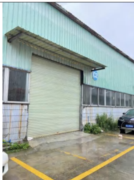
项目东南面 a：B 仓厂房
