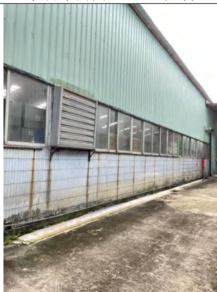
项目西南面 a：C 仓厂房
