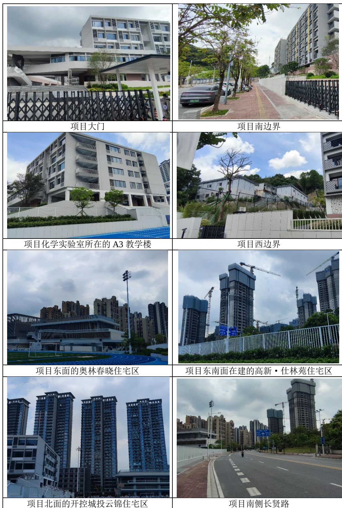
附图 4 项目所在地内现状及四至实景照片
