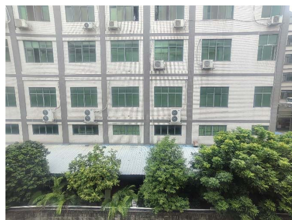
项目北面广州维格斯生物科技有限公司
