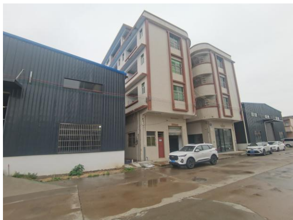
生产车间 1 号南面紧邻广州市兴怡鑫五金制品有限公司及其工业园宿舍楼
