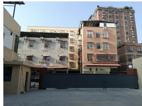
项目北面--商铺及居民楼
