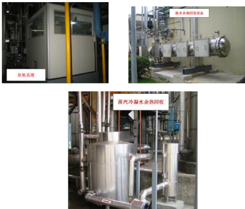
图 项目现场实拍图
