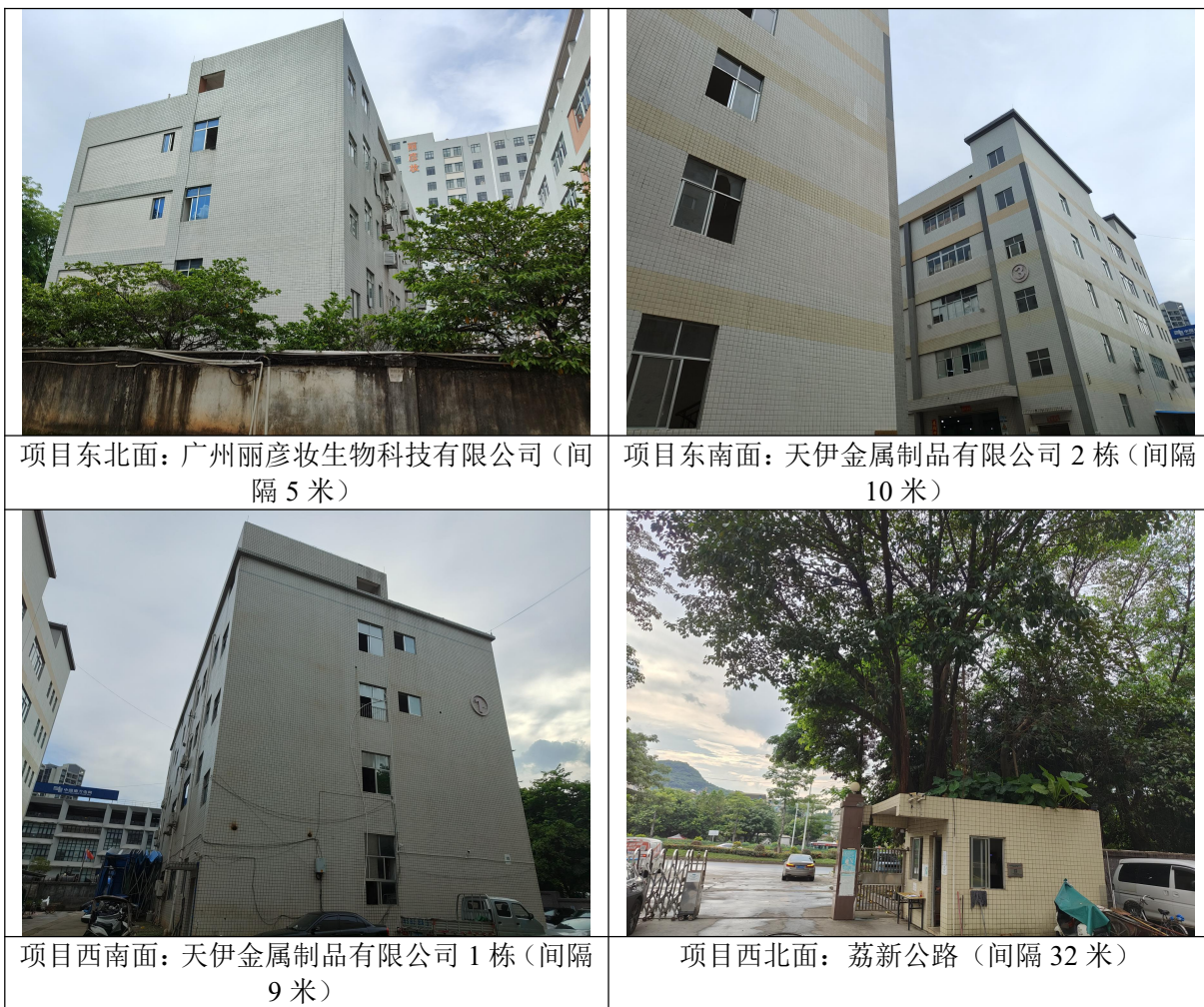
附图 3：项目四至及厂房内部照片
