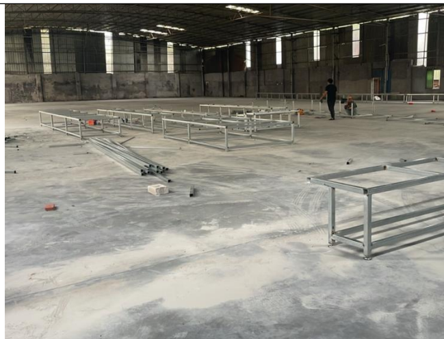
项目内部照片
