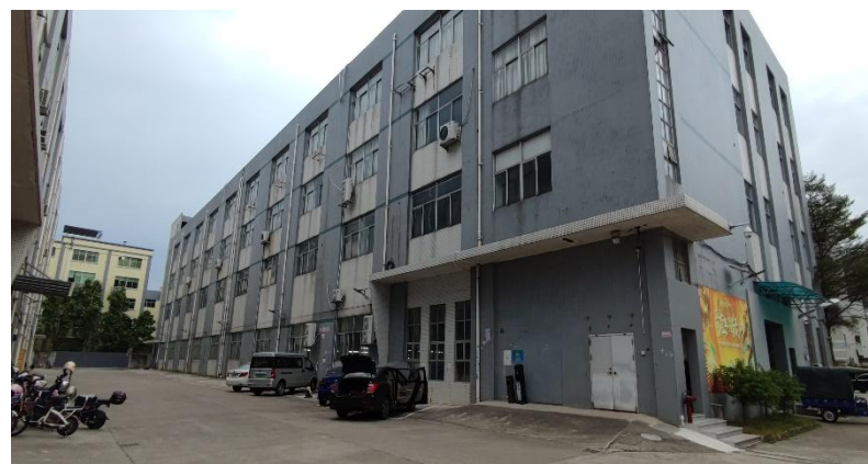
(2号厂房西面、6号厂房北面) 园区7号厂房
