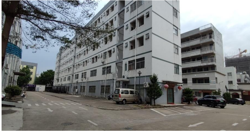
(2号厂房西面) 园区8号宿舍楼
