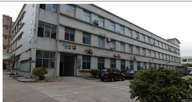
(2号厂房北面) 园区1号厂房
