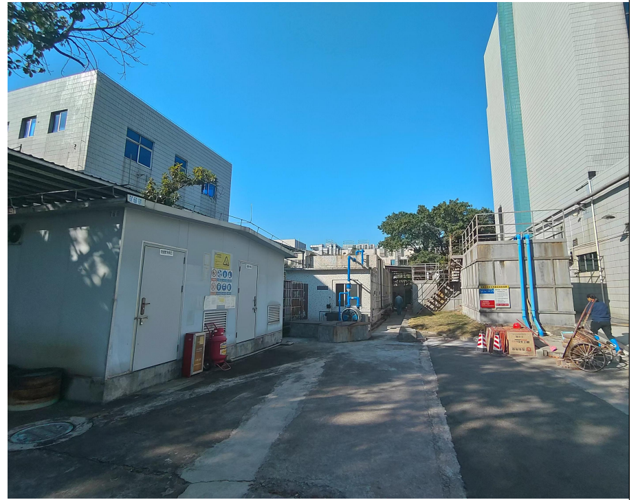
南面：厂区污水处理站区域
