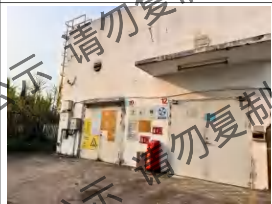
19号危险废物暂存间
