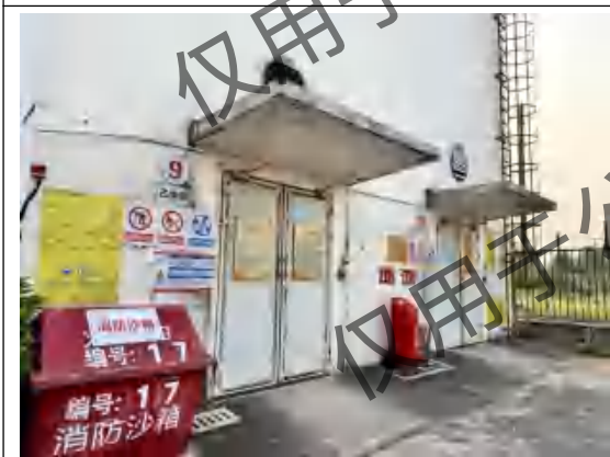
10号危险废物暂存间
