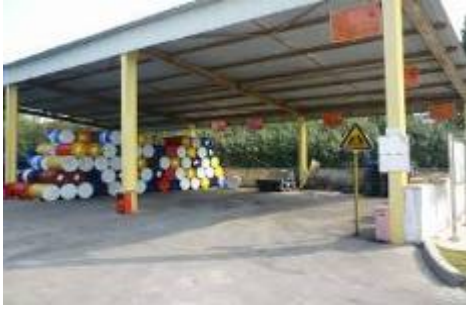
危险废物存放场
