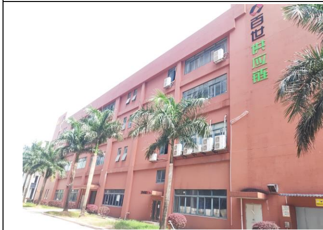
项目南面-霸王工业园现有厂房
