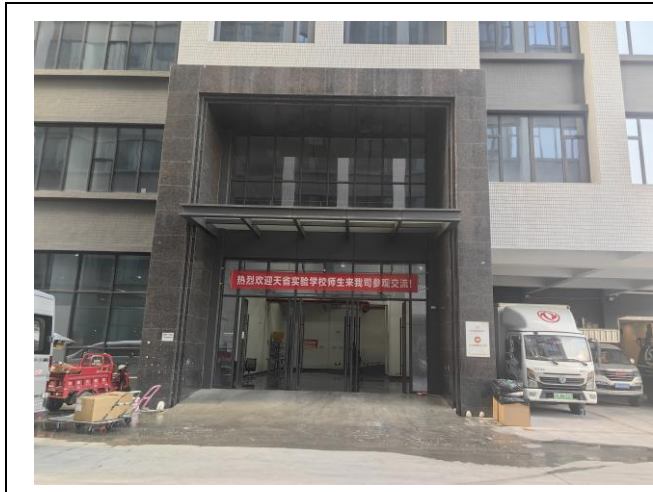
项目北面-霸王工业园在建厂房
