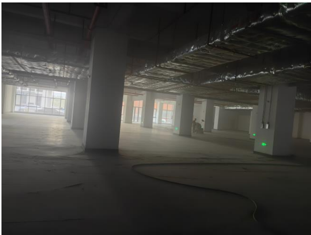
项目空厂房照片
