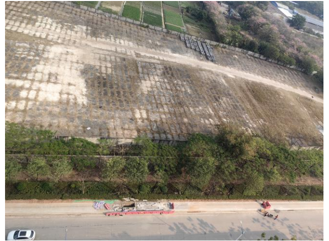
项目东面-空地
