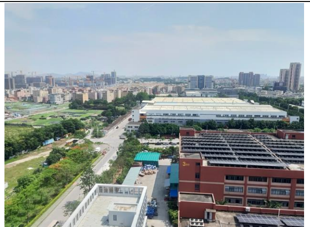
项目西面-霸王工业园现有厂房
