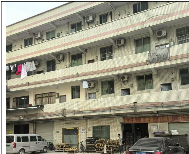
东面-工业区办公宿舍楼
