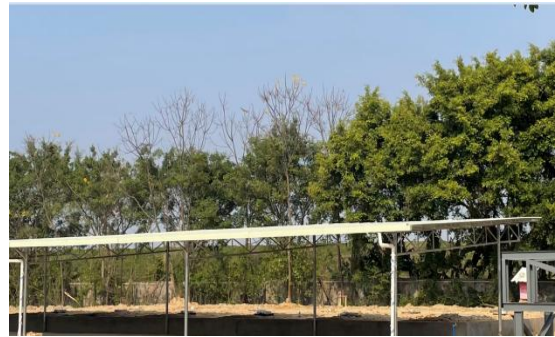
东面与联合排洪渠间的坝
