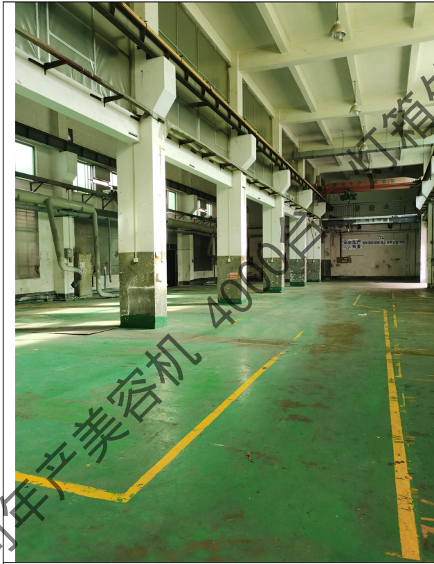
本项目厂房内现状
