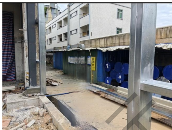
现有项目危险废物暂存间
