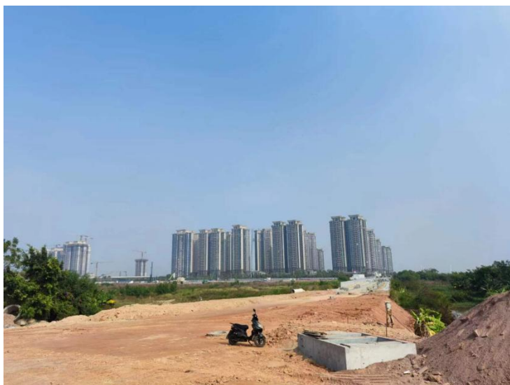
项目西面-在建厂房
