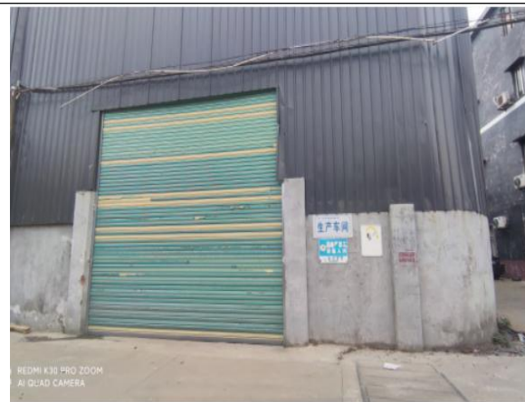
项目西面-空厂房
