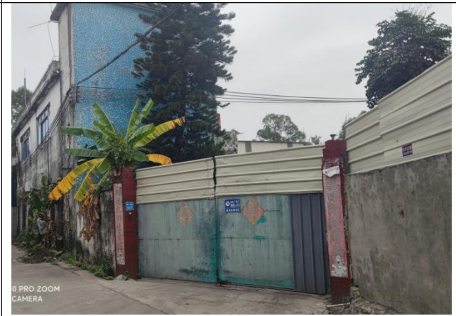
项目北面-空厂房
