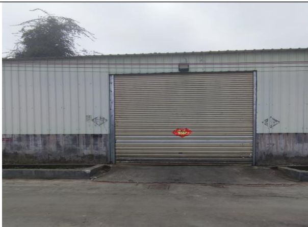
项目南面-空厂房
