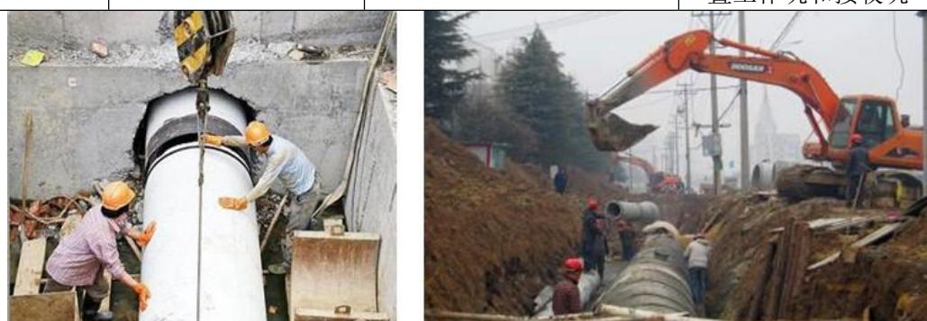
图 2-3 顶管施工与开挖施工图
