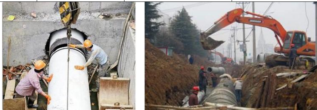
图 2-3 顶管施工与开挖施工图
