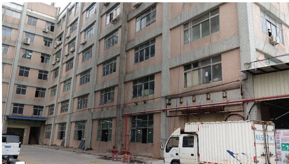
项目西面-合坚公司厂房
