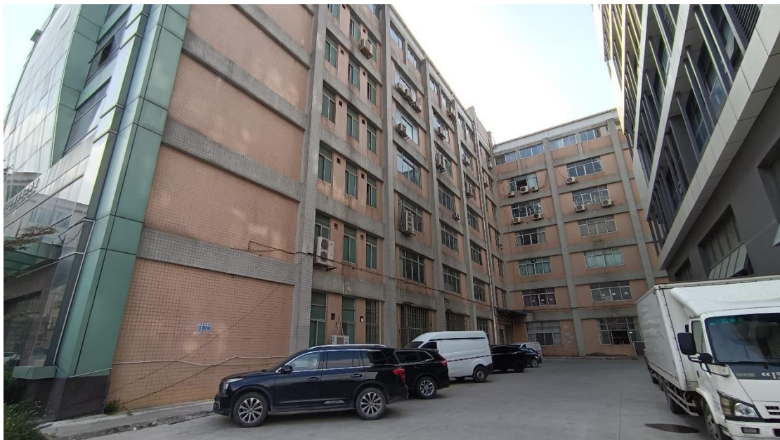
项目南面-合坚公司厂房
