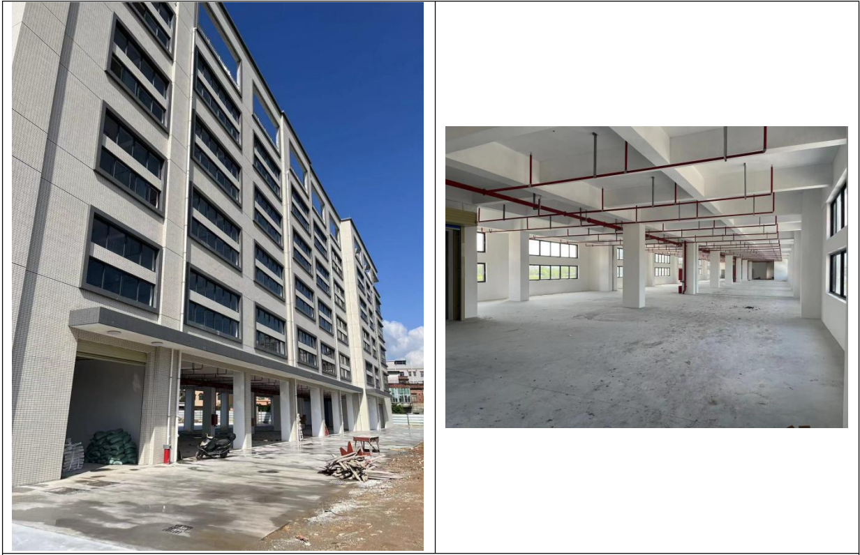
厂房内部现状照片
