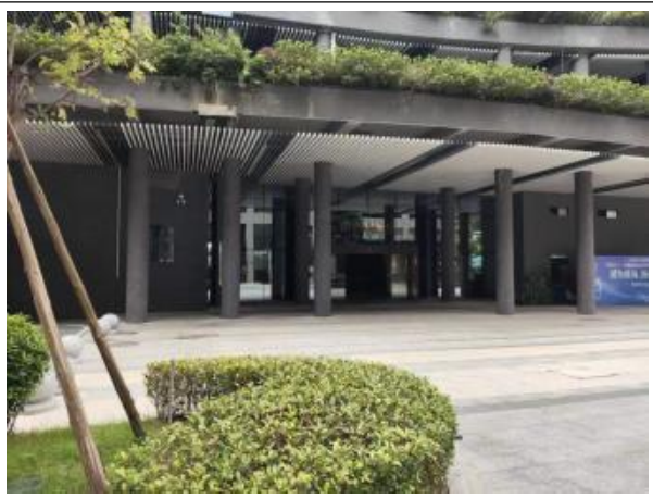
东南面：园区 E 号楼
