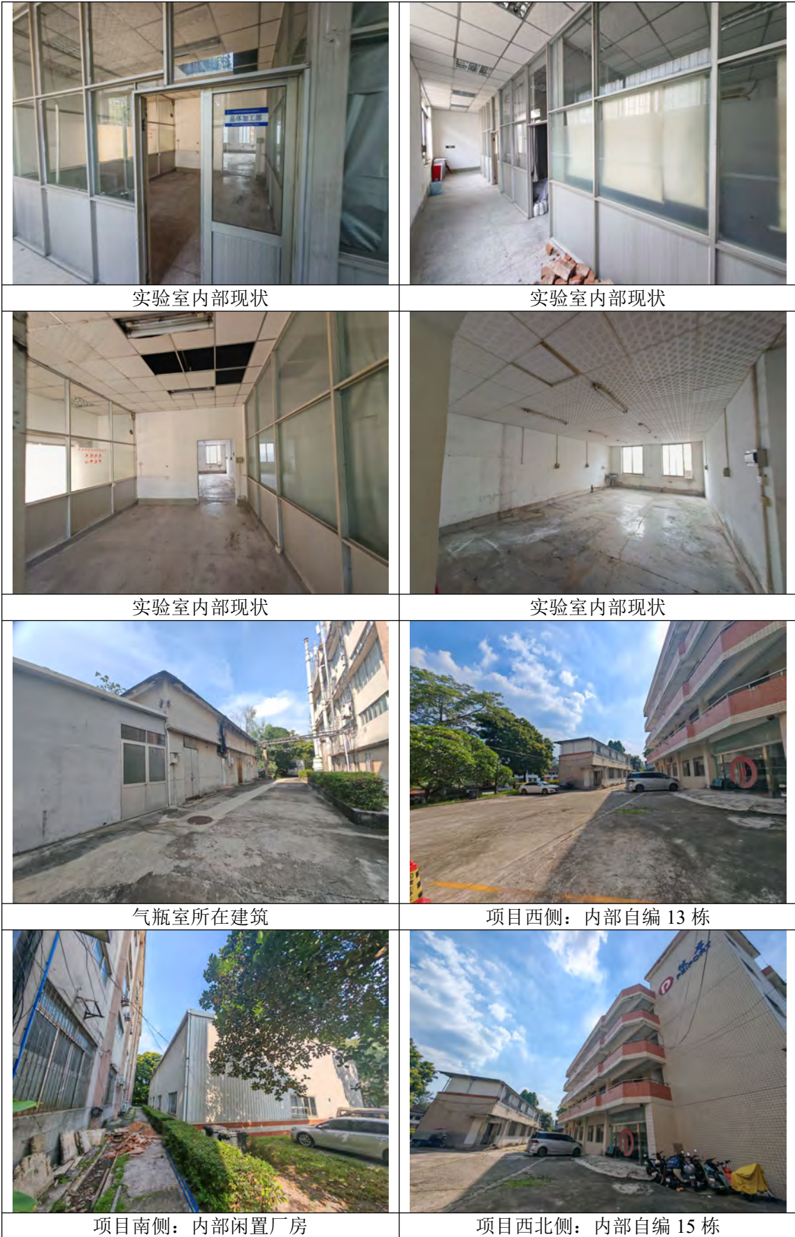
附图 3 本项目四至实景图及厂房内现状图
