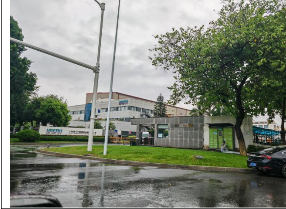
西面广州西门子能源变压器有限公司
