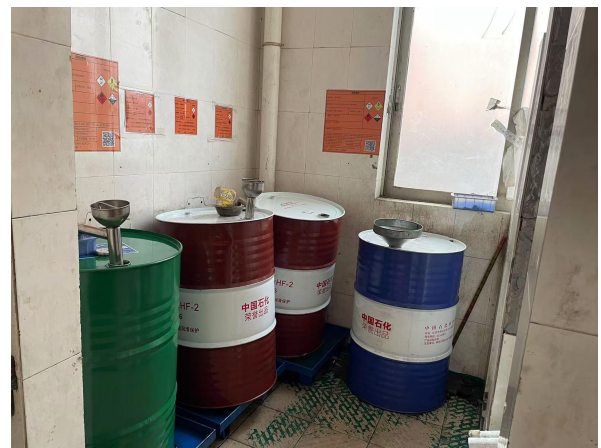
危废仓（有标示、防渗、照明）
