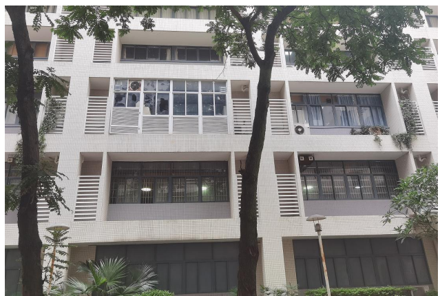
项目西面（约 5m）：办公楼
