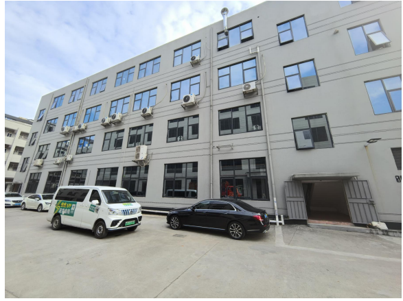
南面-厂区空地及厂房
