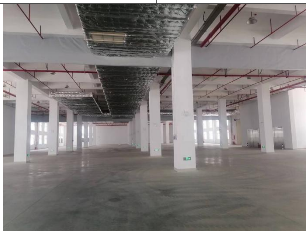
项目内部现状
