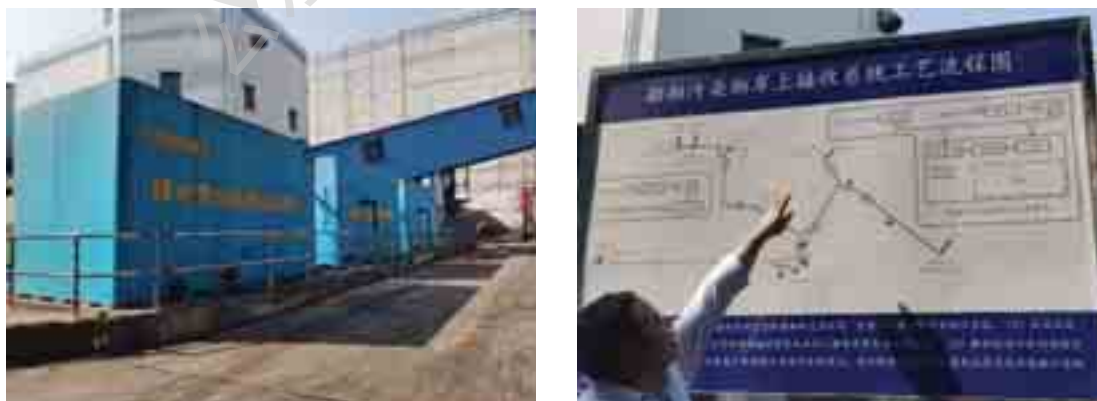
图 3.12-5 含油废水处理站现状照片
