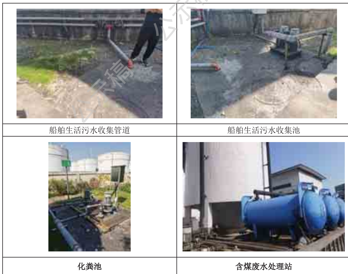
图 3.12-4 生活污水收集、治理设施现状照片
