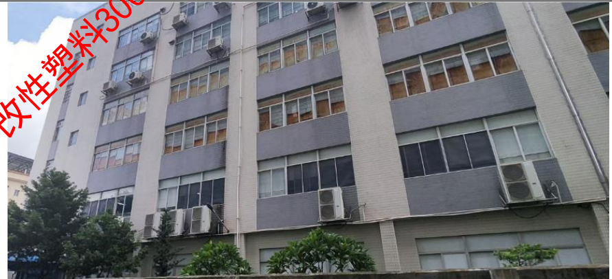
项目北面：增城集中作业中心
