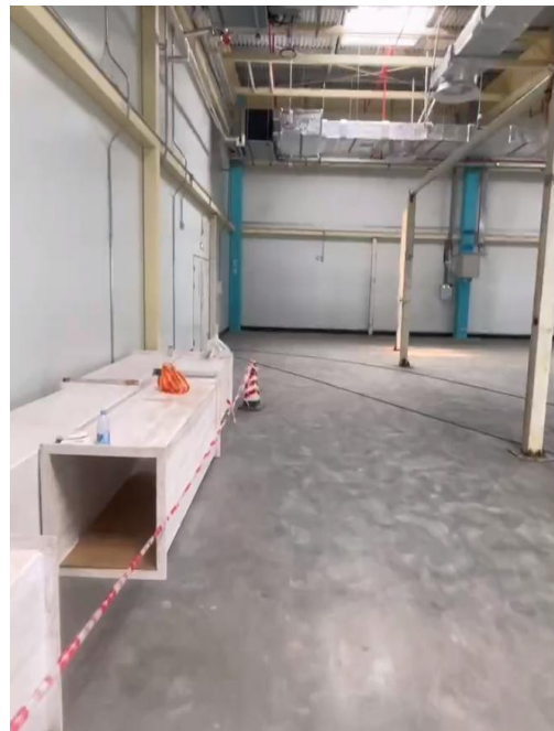
射线设备室东侧过道
