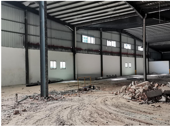
北面闲置厂房现状
