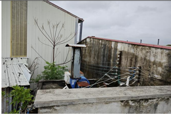
项目油烟排放烟道
