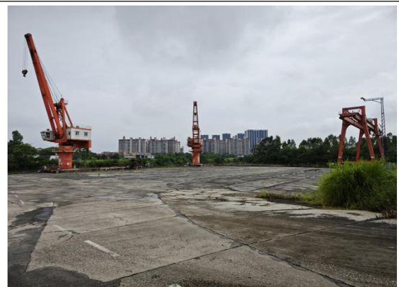
项目现状吊机
