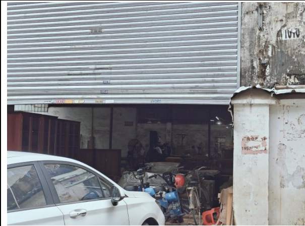
项目西南面-家具厂
