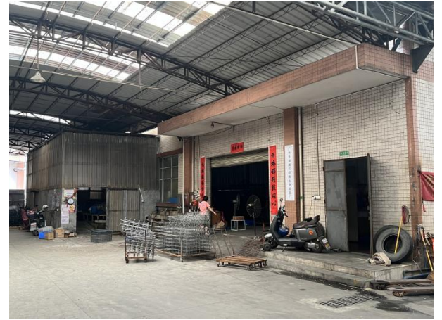
西南面：广州市增城兴桥辉五金制品厂
