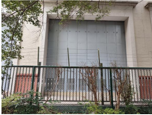
110kV 珠吉变电站东南侧外环境
