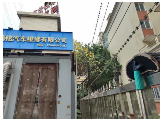
110kV 珠吉变电站东北侧外环境
