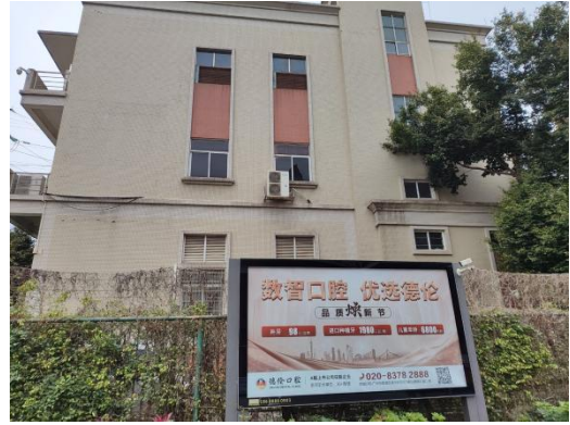
110kV 珠吉变电站西南侧外环境
