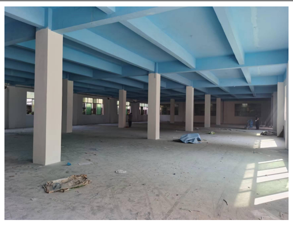
项目情况（空厂房）
