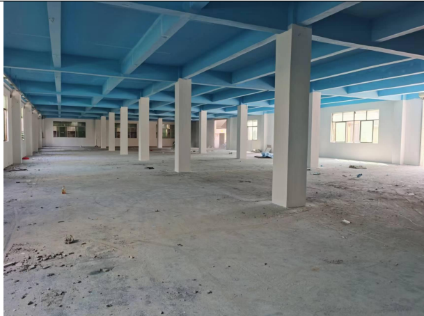
项目情况（空厂房）
