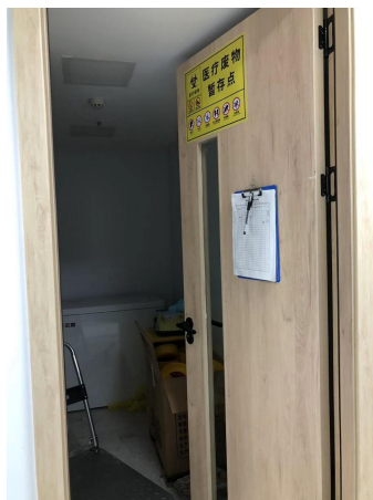
图 2-6 医废危废暂存间
