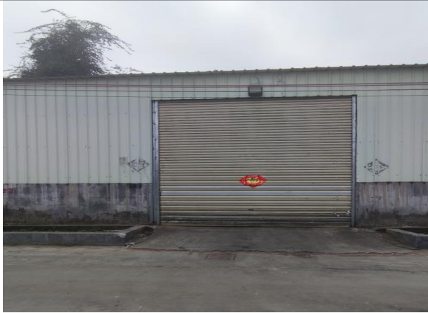
项目南面-空厂房
