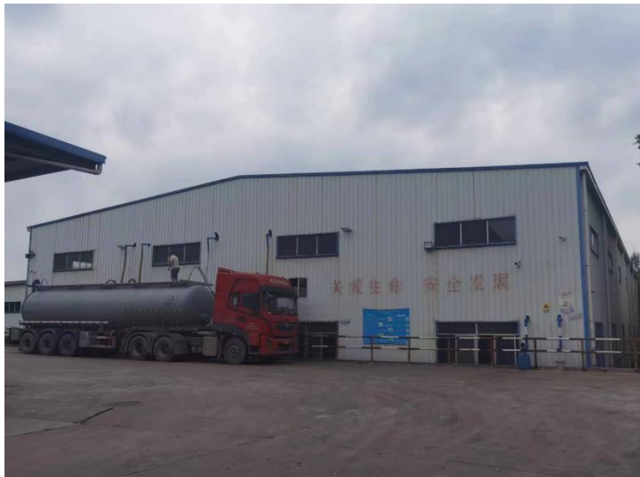
西南面广州市建筑科学研究院有限公司
