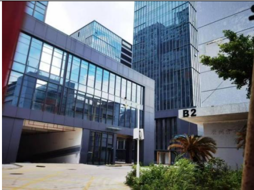
西面：广州钻汇国际创展汇（在建）
