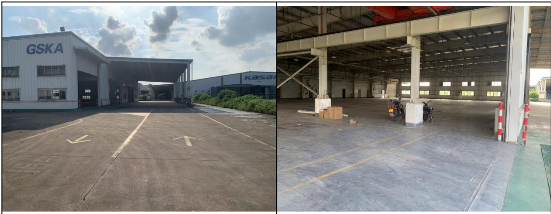
建设项目车间现状
