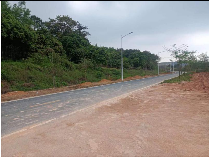
项目东面-Y321 乡道
