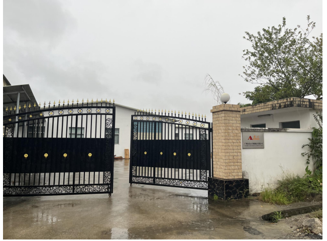
项目北侧广州安心生物制品有限公司
