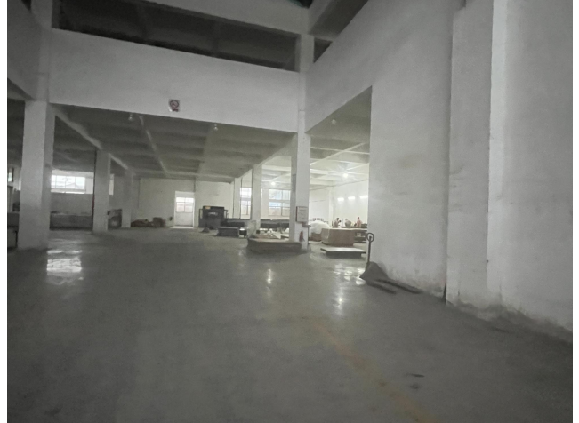
本项目生产车间
