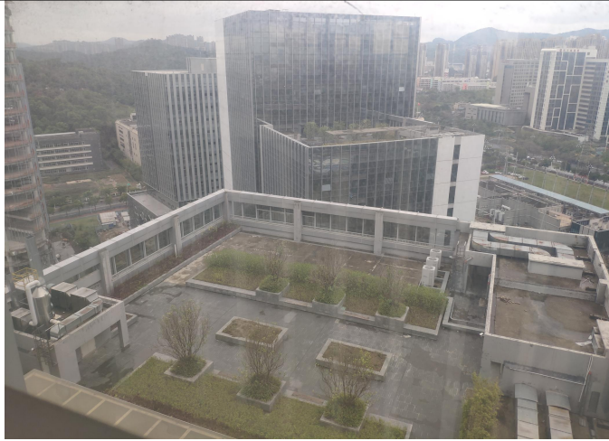
项目东北面：京广协同中心 2 号楼
