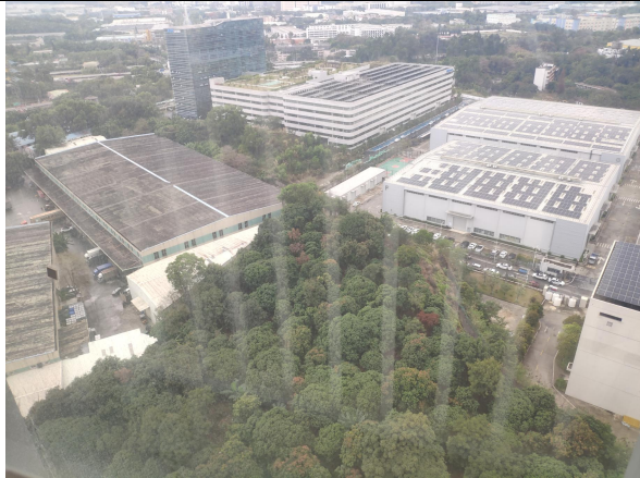
项目西南面：工业厂房
