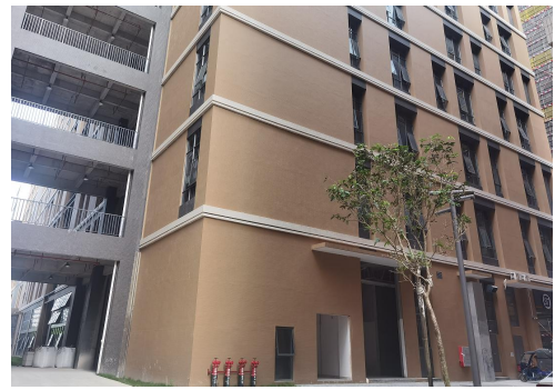
项目所在建筑 8 栋
