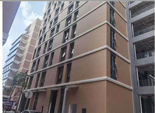
项目西北侧（约 16m）：所在园区 7 栋厂房
