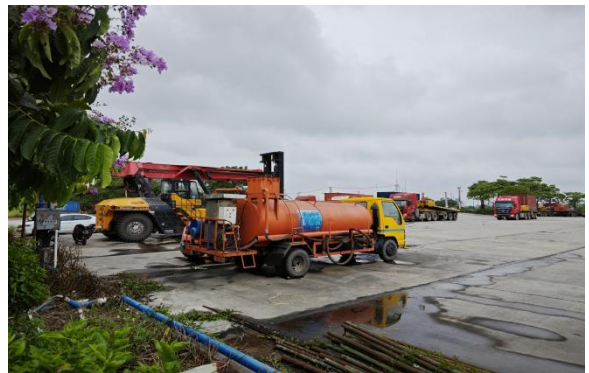
项目现场洒水车
