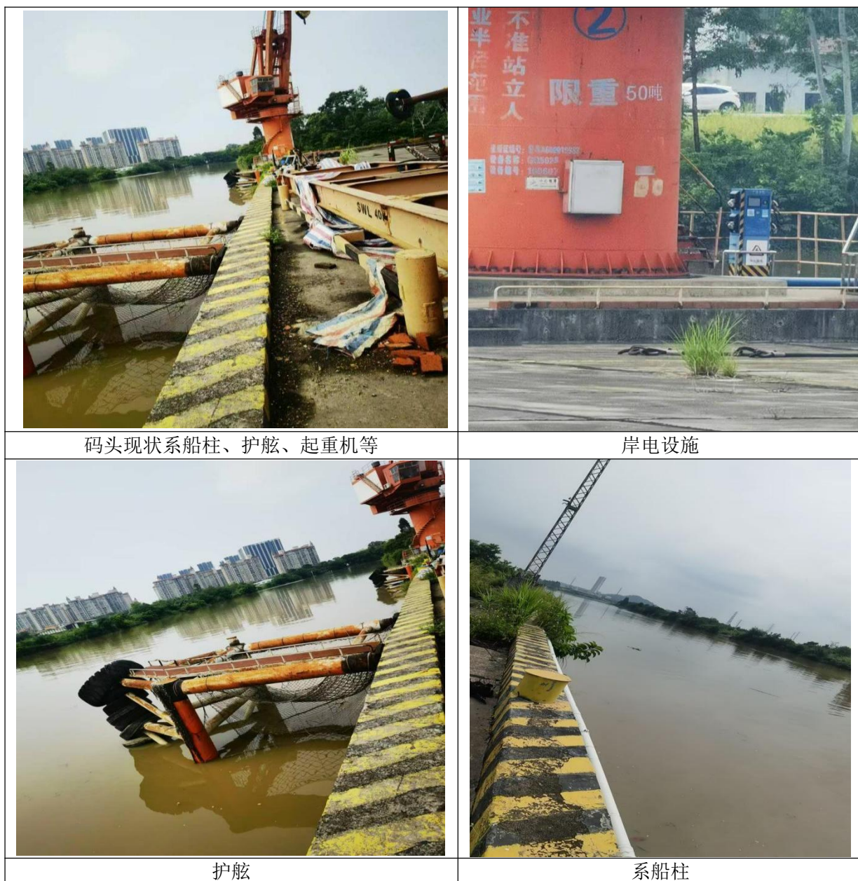
图 2-1 码头现状配置部分设施照片图
