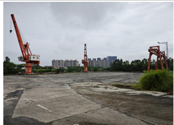
项目现状吊机
