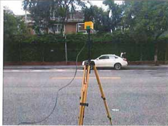
Picl 电力隧道检测断面
